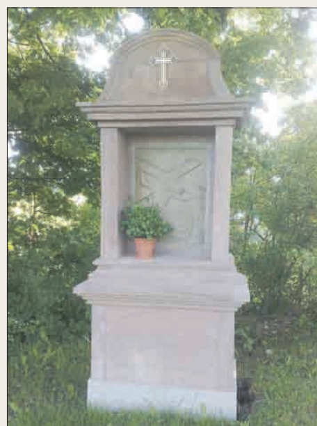
Die 7. Station nach der Restaurierung
