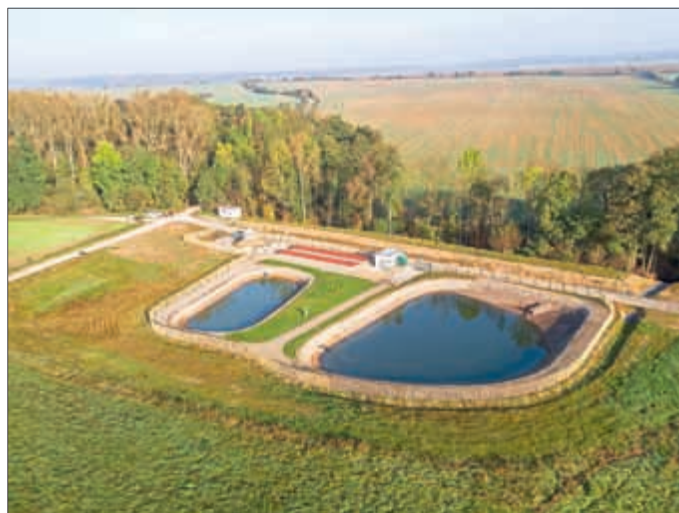
Die Kläranlage Schildbach leistet einen wesentlichen Beitrag zum nachhaltigen Umwelt- und Gewässerschutz gemäß den Anforderungen der Europäischen Wasserrahmenrichtlinie.
